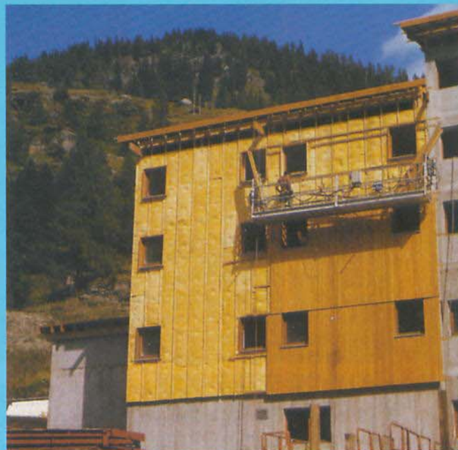
Instalación de Lana Mineral en fachada
