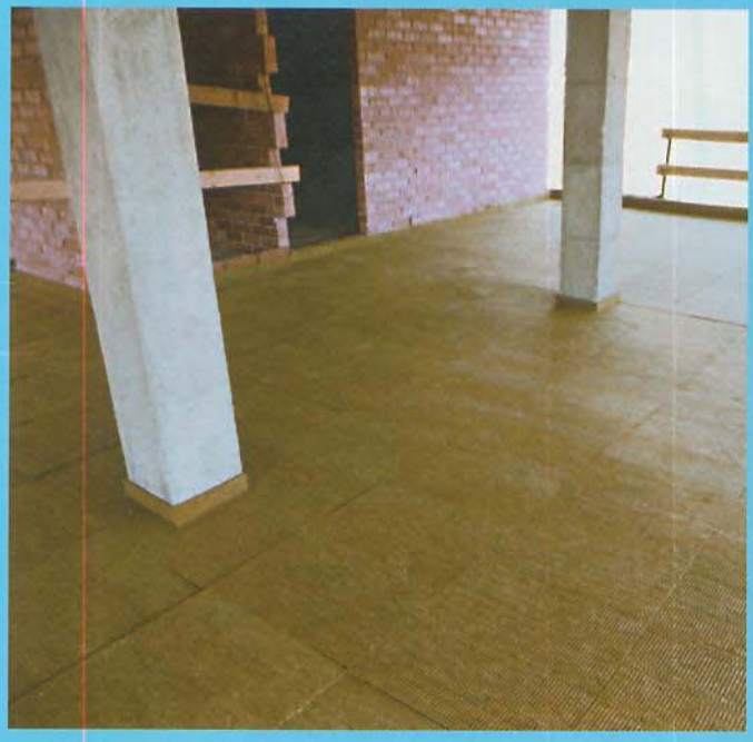
Instalación de Lana Mineral en suelo terminado
