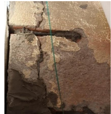
Cosido de grietas en soporte mediante grapas metálicas
