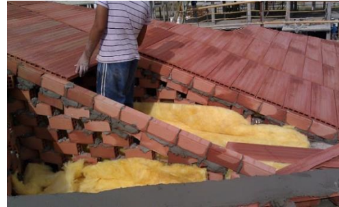
Imagen 3. Cubierta con tabiques palomeros Fte: autorizado por autor Javier Pinilla
